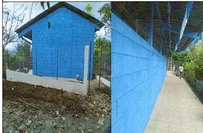
Foto 4: Pintura de los módulos, cambio de piso en el corredor y circulación perimetral con malla metálica.
