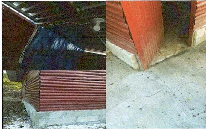
Foto 2: Mejoramiento de cocina, instalación eléctrica, banqueta, block, entre otros.
