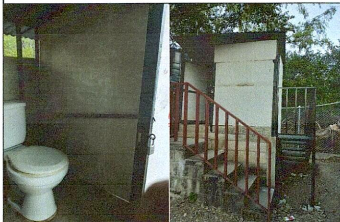
Foto 3: Mejoramiento de baños en el cambio de puertas, separar los baños con tabla yeso, instalación de gradas y banquetas.
